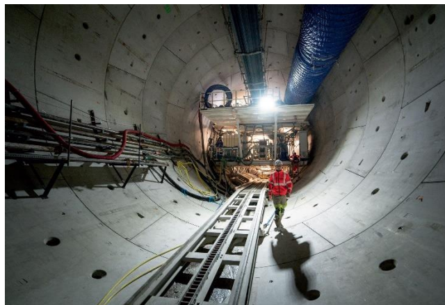
Fig. 7 Les anneaux constituant les parois d'un tunnel
