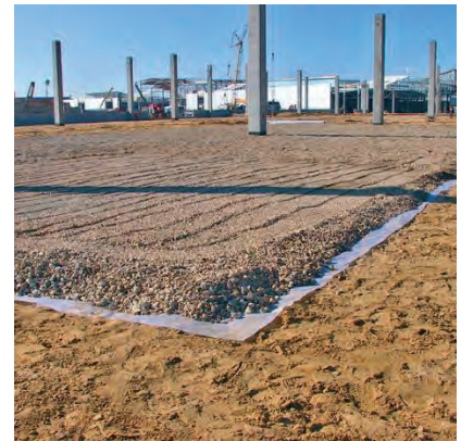
Fig. 1 - Pose de géomembrane
